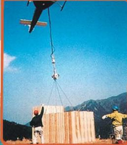
直升机吊入设备、将卫生间上下两部分构件合体
